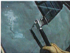
ピック部を使用しガラス、板金等の破壊、コンクリート等の削岩
