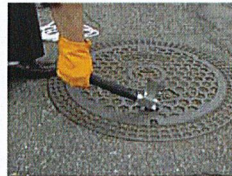
マンホールの蓋開け
